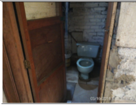
Fotografía 6. Baño del restaurante
